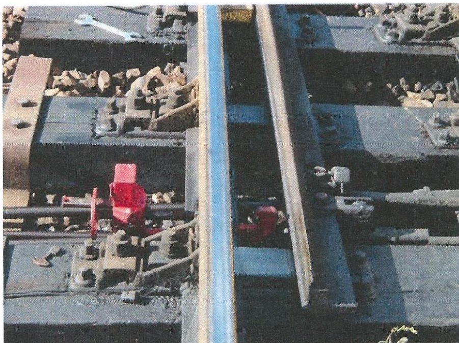
Założony zamek zwrotnicowy iglicowy – spona iglicowa, zabezpieczająca iglicę odlegającą.
