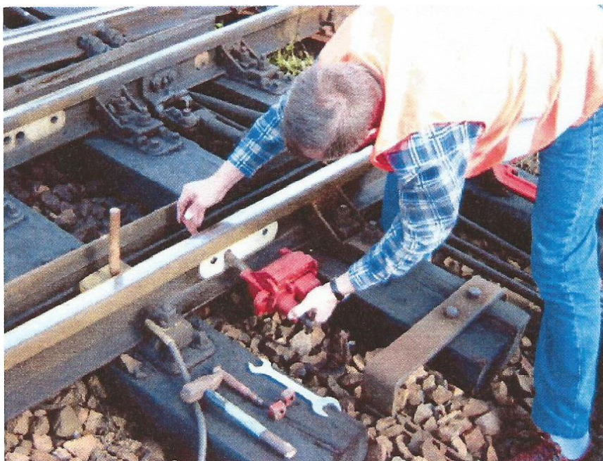
Sposób zakładania zamka zwrotnicowego trzpieniowego do zwrotnicy rozjazdu
